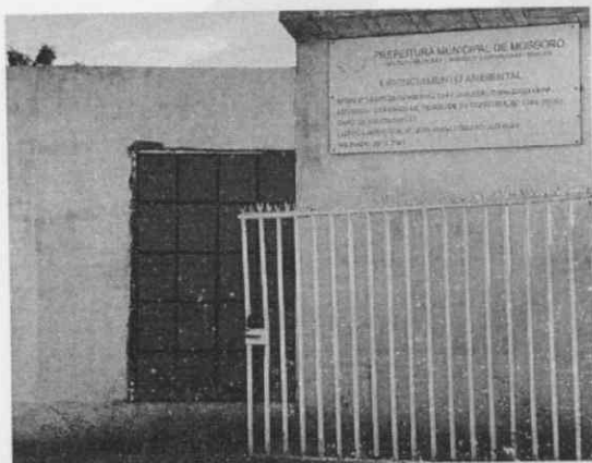
Foto 01 – Placa da licença ambiental na fachada
