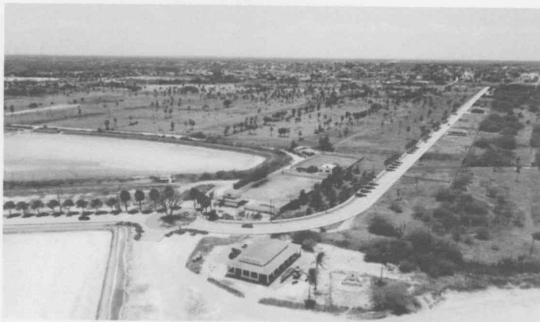
IMAGEM 01 VISTA GERAL DA VIA PROJETADA
