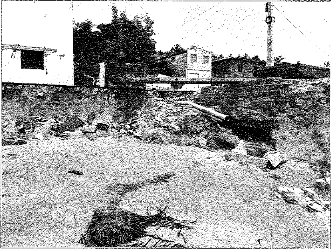
Figura 2 - Erosão na Praia da Redonda.
