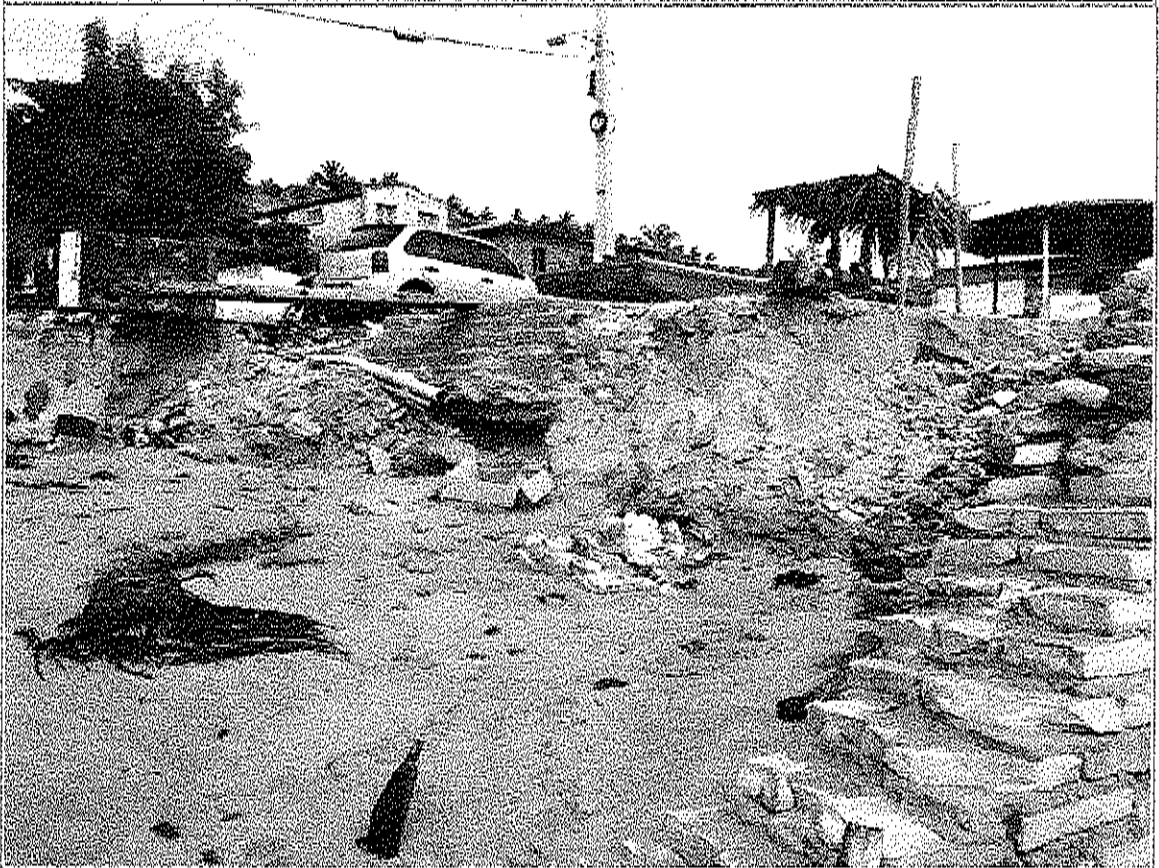
Figura 1 - Erosão na Praia da Redonda.
