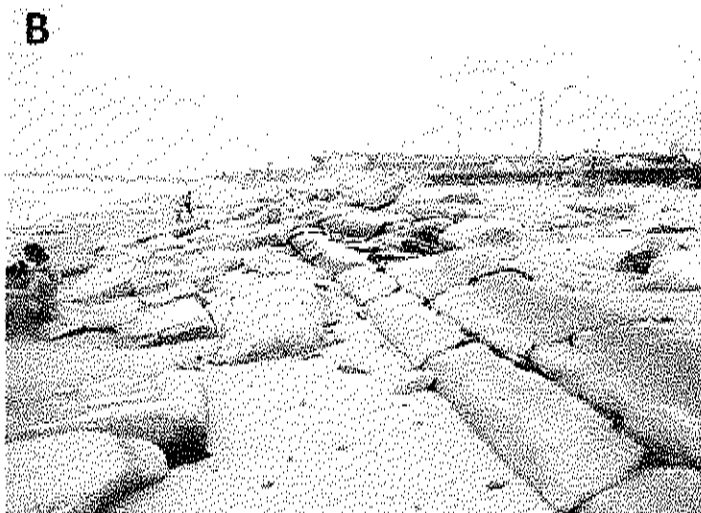
Figura 19 – Solapamento da estrutura impermeável (Bagwall) e degradação do ambiente praial na Praia de Icarai/CE.
