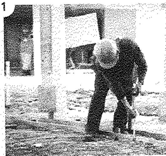
Fixação da forma de forma que o topo coincida com a superfície de rolamento prevista em projeto. Deve-se garantir espessura uniforme ao longo de todo o pavimento.
