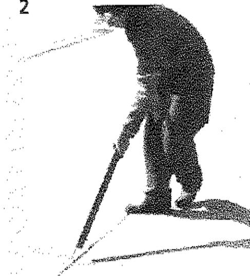
Após o corte das juntas, procede-se a limpeza com ferramentas com ponta arredondada, que penetre no recesso das juntas, e jateamento de ar comprimido.
