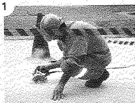
O Projeto Executivo de Engenharia deve prever juntas transversais de retração e de construção. Estas deverão ser serradas com serra de disco diamantada, assim que o concreto atingir a corte sem se danificar. A profundidade do corte deve ser especificada.
