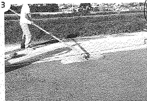
Nivelamento de superfície executado com o uso de regua de corte e desempenadeira (float) de cabo estendido e rígido.
