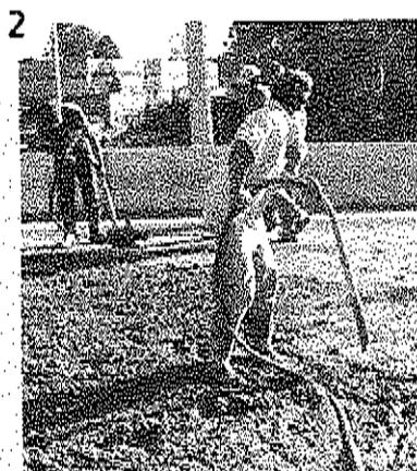
Adoçamento com o auxílio de regua vibratória no vão entre pilares.
