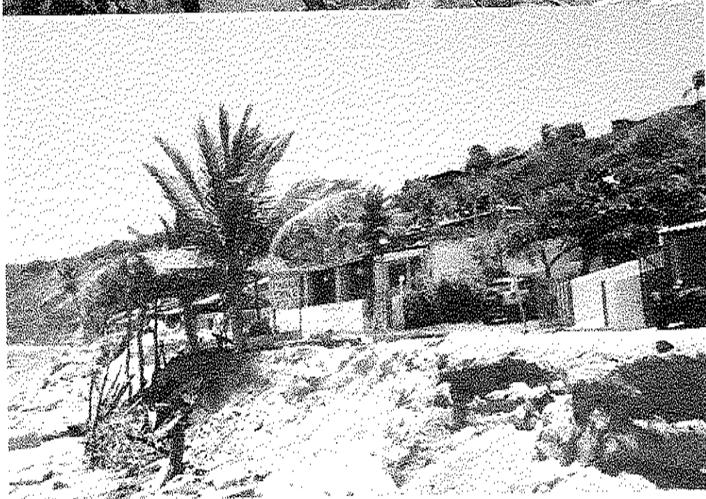
Figuras 02 e 03 – Destruição da via e comprometimento dos acessos às construções existentes na avenida beira mar da praia da Redonda, Icapuí-CE.
