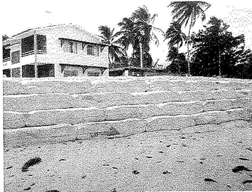
Figura 100 – Estrutura do tipo de bagwall (bolsacreto). Praia da Croa, Alagoas-RN.
