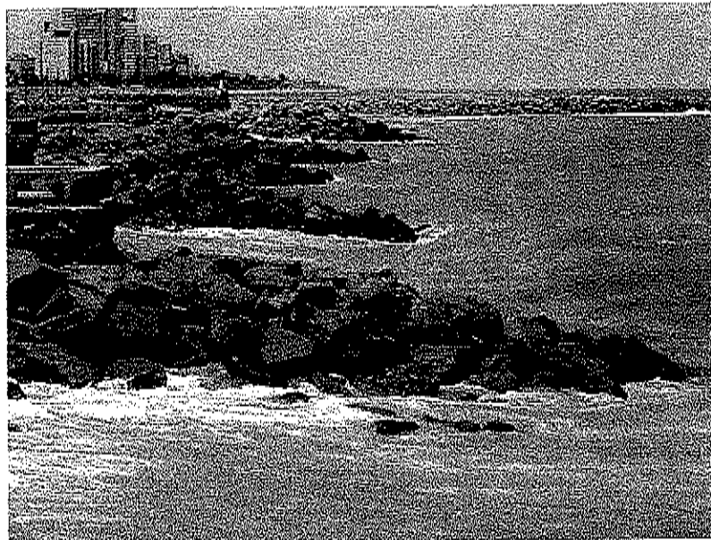
Figura 97 – Bateria de espigões, Praia de Bairro Novo, Olinda/PE. Fonte: Acervo (2011)
