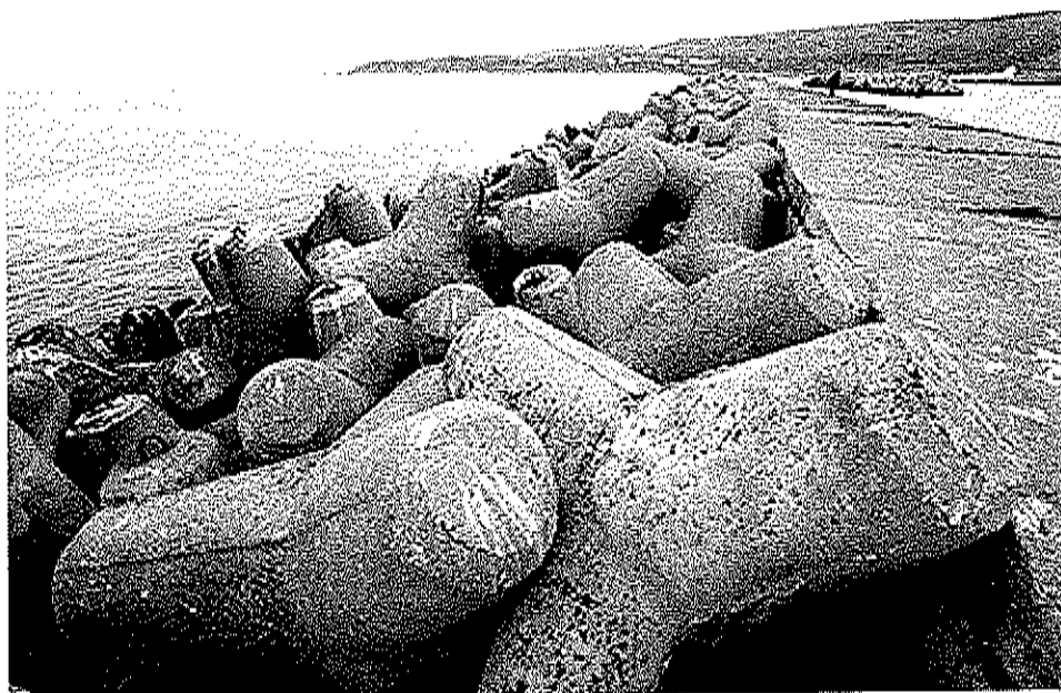
Figura 104 – Enrocamento aderente com uso de blocos de concreto tetrápode.
