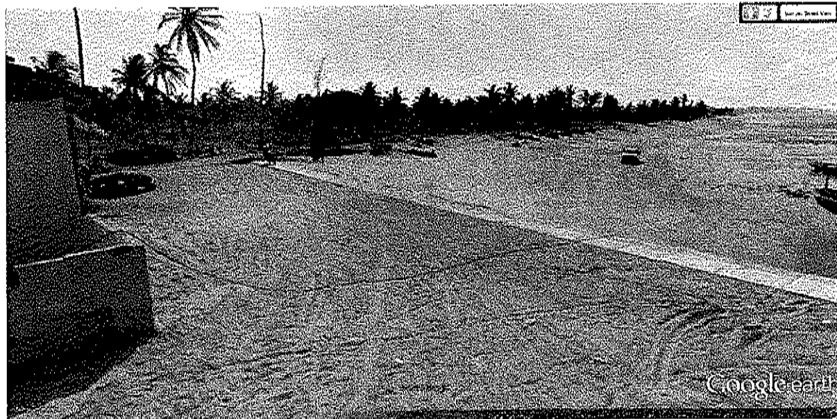
Figura 51: Estrutura de defesa costeira estabilizando parte da linha de costa da praia de Barrinha. Fonte: Imagens históricas do Google Earth (2012).
