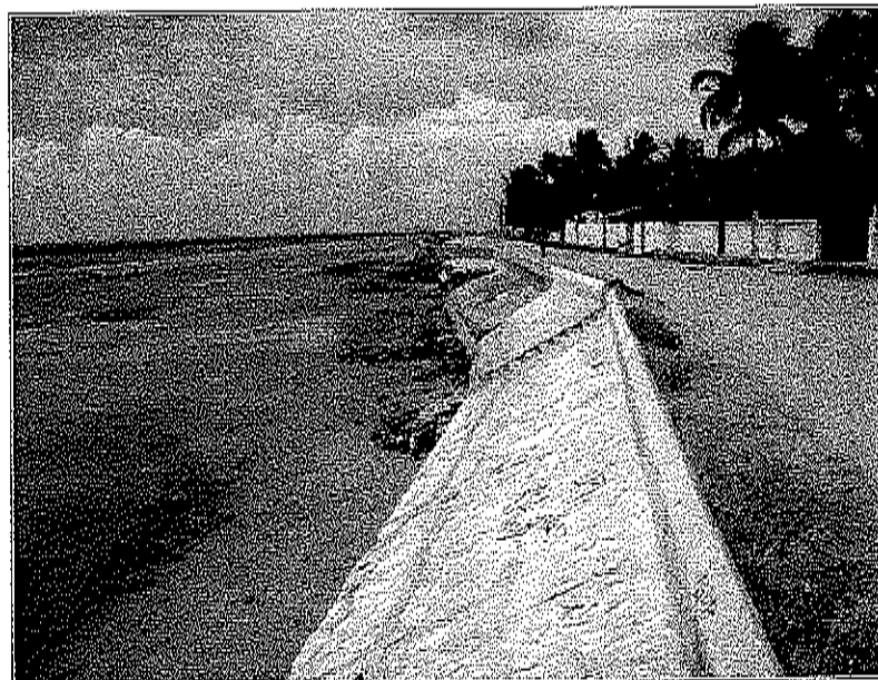
Figura 98 – Tipo de seawall. Fonte: Extraído de Gois (2011)
