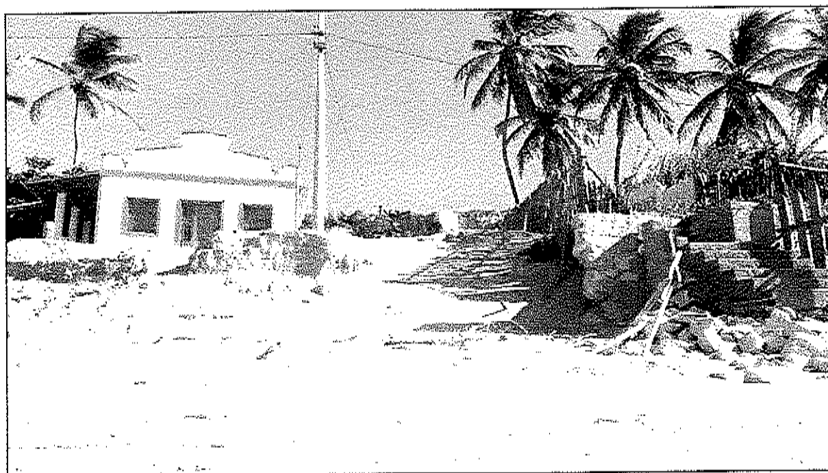
Figura 41: Rua que se encontrava afastada 17,30 metros da linha de costa, na praia de Peroba, Icapuí, atualmente atingida pelo processo de erosão costeira.
